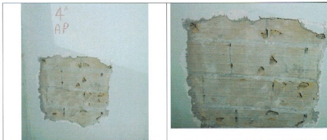
Apertura AP4 : Muratura in mattoni forati in laterizio, con rivestimento di intonaco.
