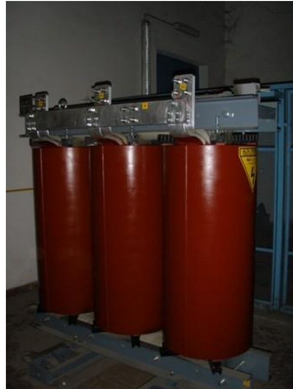
Trasformatore da 400 \ 15.000 V
