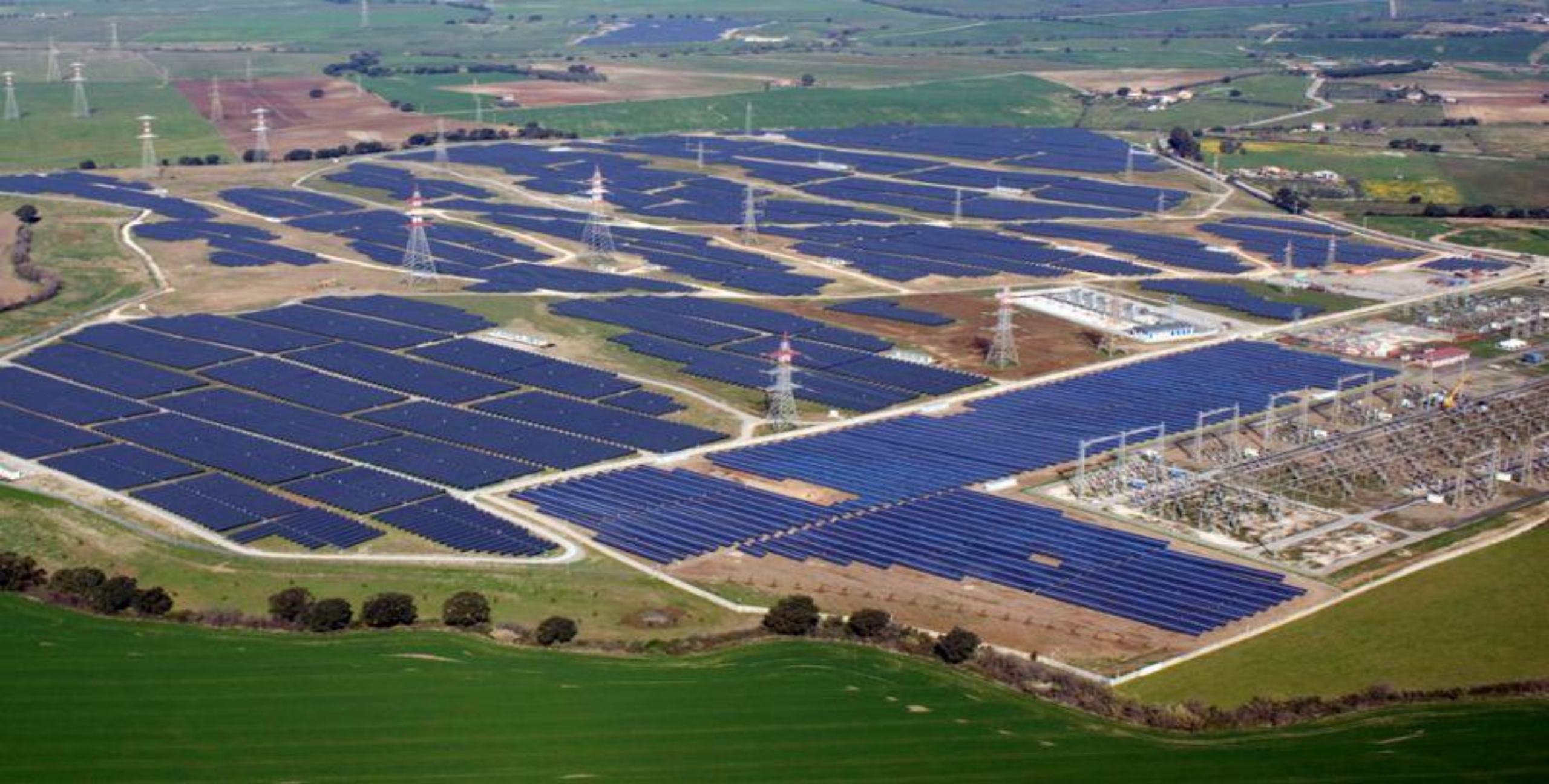
VITERBO : IL PIU' GRANDE PARCO SOLARE FOTOVOLTAICO ITALIANO DA 84,2 MW p
