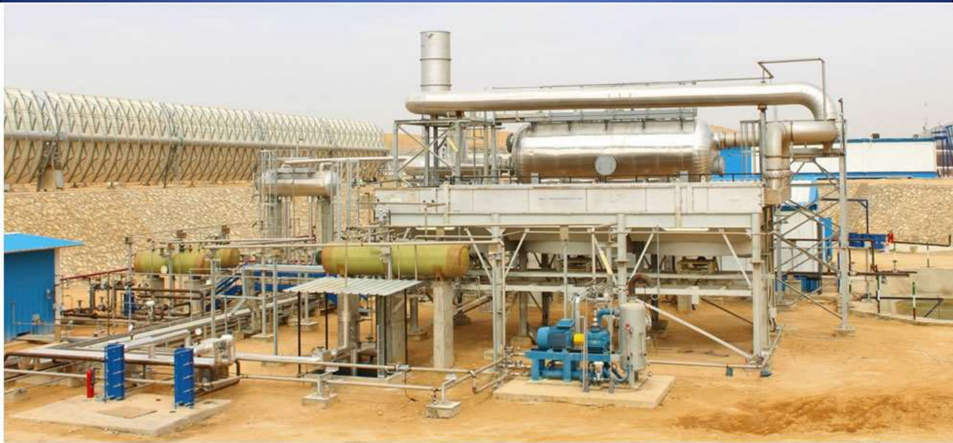
Impianto co-generativo con unità di desalinizzazione
