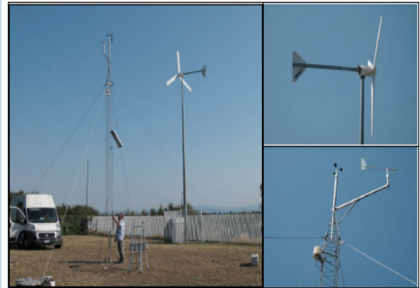
Fig. 5.5 – Miniaerogeneratore da 2 kW e torre anemometrica installati a Cesenatico.
