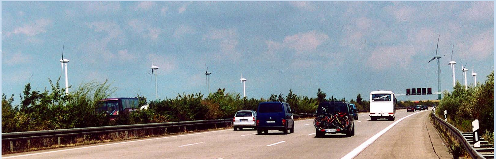
Aerogeneratori ed infrastrutture stradali in Germania
